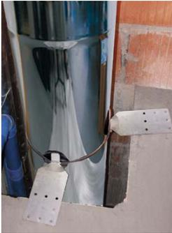
Die Rohrschelle mit Gummieinlage wird um das Rohr montiert.
